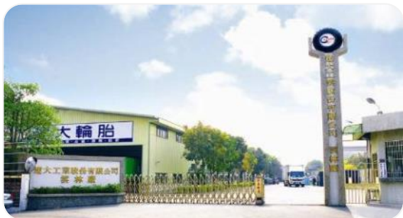
1985 雲林工廠 Yunlin plant
