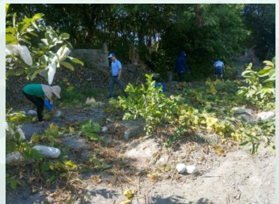
協助廠區鄰居里民整理農地雜木
