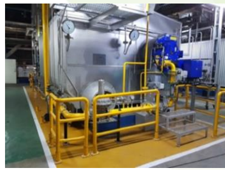
重油鍋爐改為天然氣鍋爐
