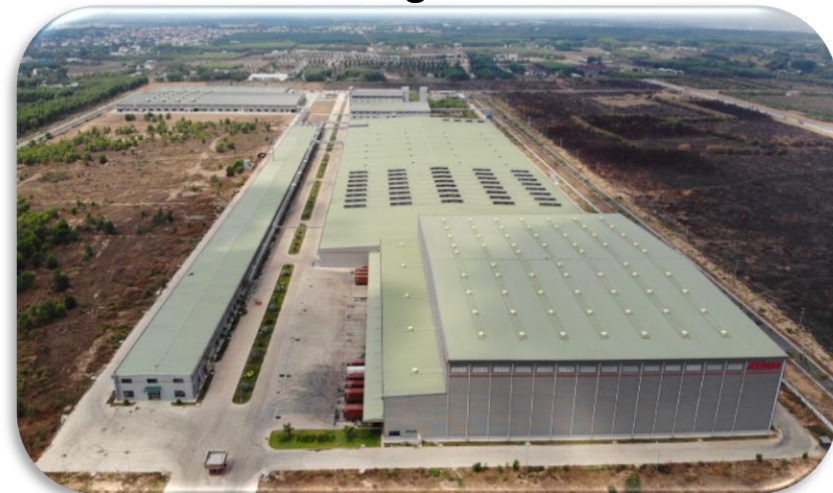
越南第二工廠 2 nd Vietnam plant
