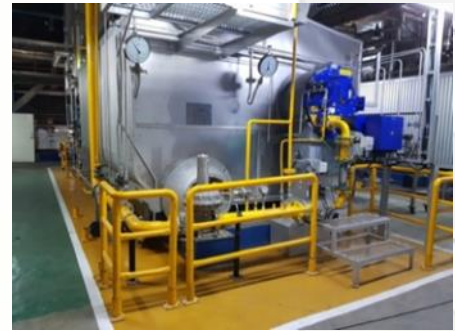
重油鍋爐改為天然氣鍋爐
