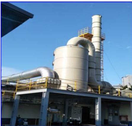
外胎硫化區水洗塔廢氣處理設備
