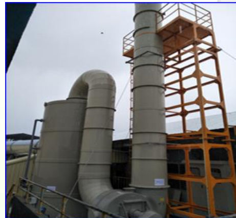
內胎硫化區水洗塔廢氣處理設備
