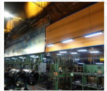
硫化區設置鋁板
