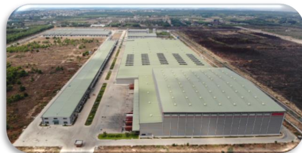
越南第二工廠 2 nd Vietnam plant
