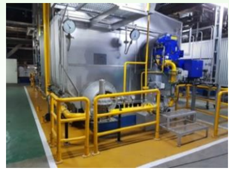
重油鍋爐改為天然氣鍋爐
