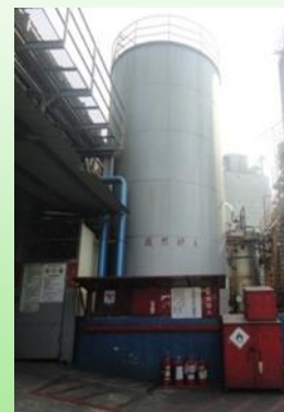
重油儲槽防溢堤
