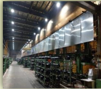
硫化區設置鋁板
